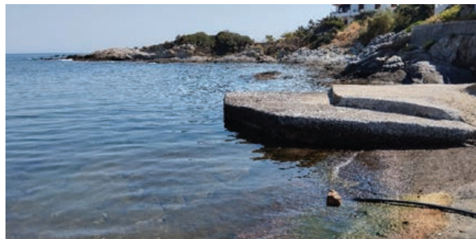
Σωλήνας απόρριψης λυμάτων κατευθείαν στη θάλασσα.
