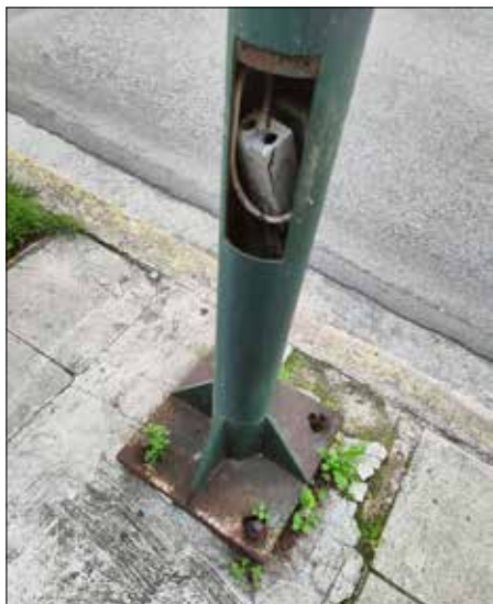
Σημείο 9: Οδός Αθανασίου Καρπεννησιώτη. Περιγραφή ευρύματος: Σε όλο το μήκος της οδού οι κολώνες φωτισμού εμφανίζουν εκτεταμένη σήψη και κακοτεχνίες κάλυψης παραβιασμένων ηλεκτρολογικών κουτιών.
