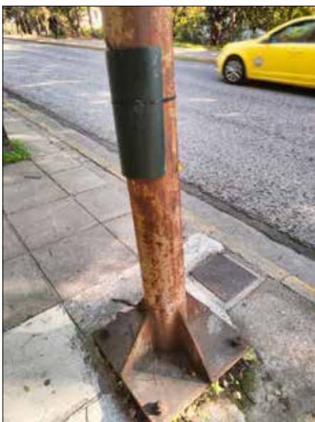
Σημείο 10. Οδός Βριλησσού. Περιγραφή ευρύματος: Οι κολώνες φωτισμού παρουσιάζουν εκτεταμένη σήψη κατά μήκος τους, ιδιαίτερα στα άνω τμήματα όπου στηρίζονται τα φωτιστικά.
