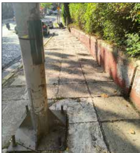
Σημείο 9: Οδός Αθανασίου Καρπεννησιώτη. Περιγραφή ευρύματος: Σε όλο το μήκος της οδού οι κολώνες φωτισμού εμφανίζουν εκτεταμένη σήψη και κακοτεχνίες κάλυψης παραβιασμένων ηλεκτρολογικών κουτιών.
