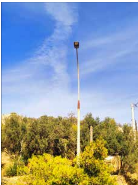
Σημείο 10. Οδός Βριλησσού. Περιγραφή ευρύματος: Οι κολώνες φωτισμού παρουσιάζουν εκτεταμένη σήψη κατά μήκος τους, ιδιαίτερα στα άνω τμήματα όπου στηρίζονται τα φωτιστικά.
