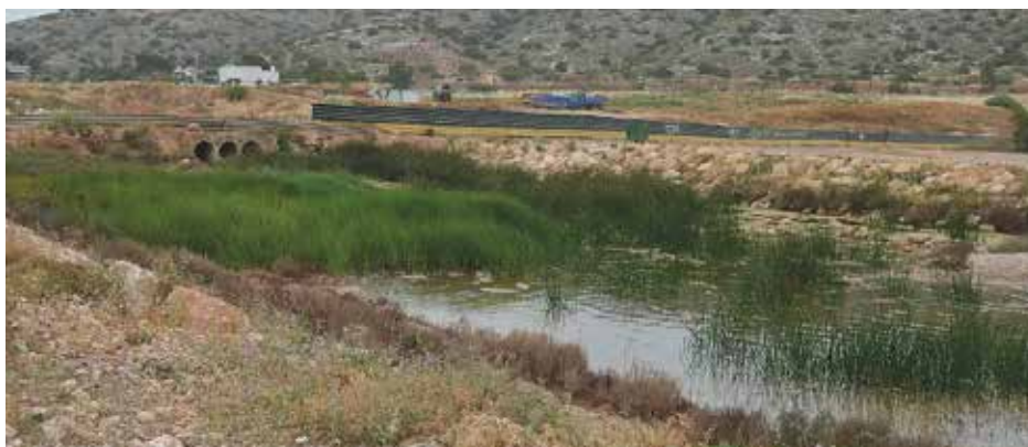
Το ρέμα στη Βάρκιζα με απόβλητα που καταλήγει στη θάλασσα
