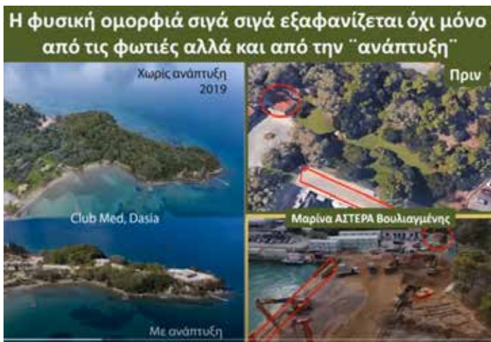
2 Στο culb Med Dasia και στην Μαρίνα του Αστήρα, το πράσινο και τα δασάκια καταστράφηκαν για να γίνουν νέες κατασκευές.
